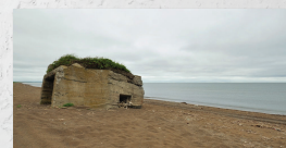
Японский дот на Сахалине. Современный вид.
